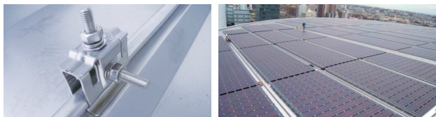
图3 光伏电池组件固定及预期效果
