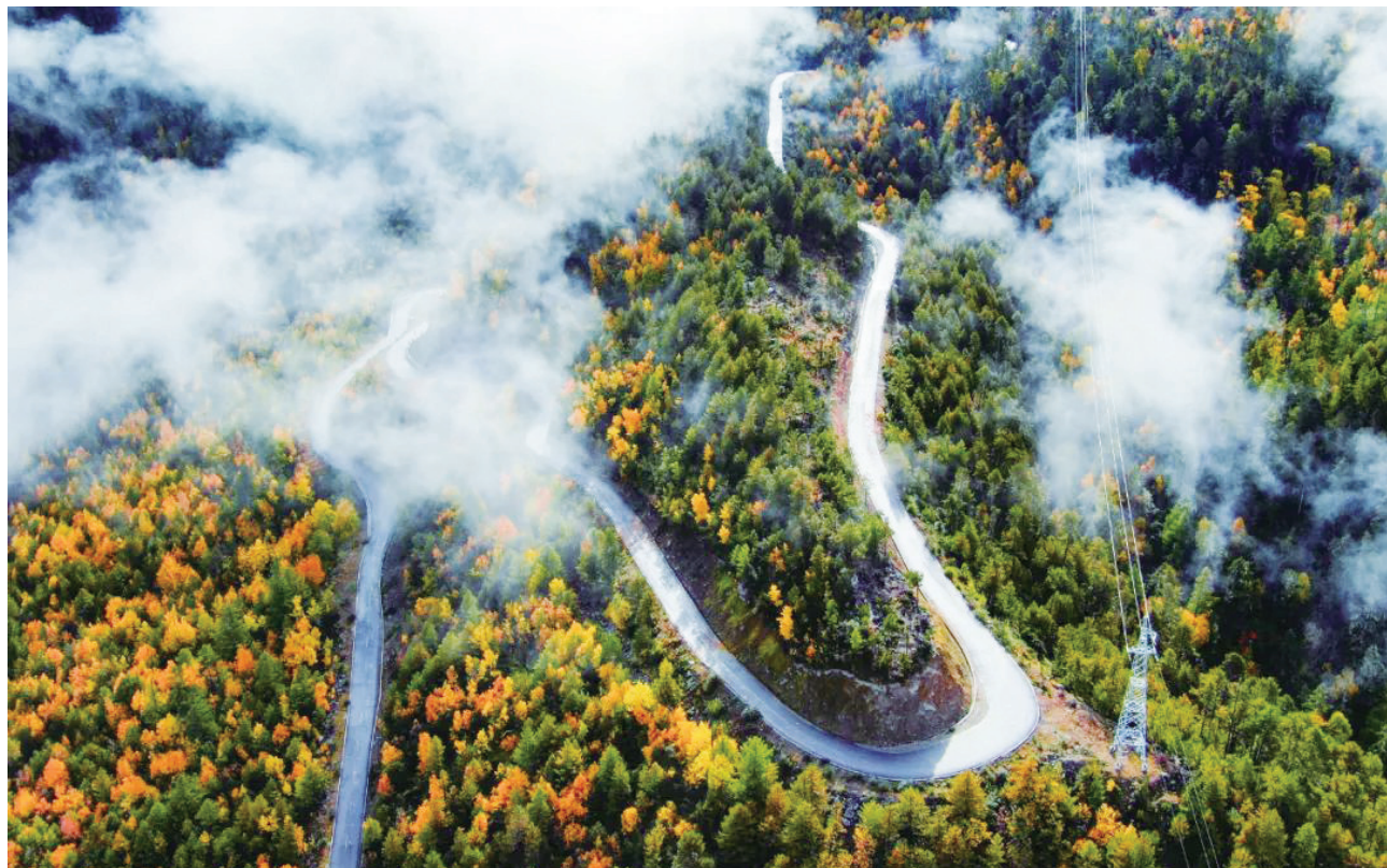
西藏重点民生工程、华能重点援藏项目——华能派墨公路
